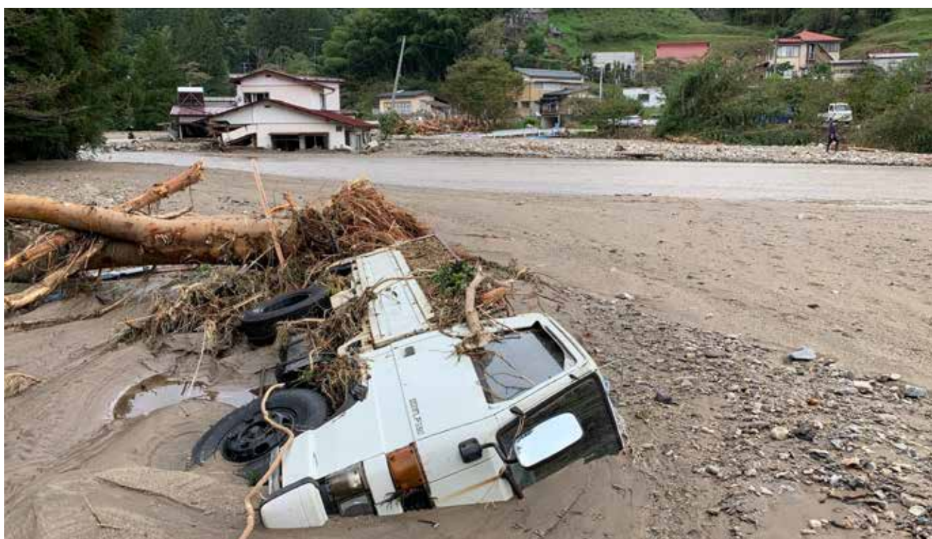
台風19号の被災者の皆さんにお見舞い申し上げます。決壊した丸森伝道者家族団地の隣の阿武隈川支流。家屋や車も流され、犠牲者も出ました。ボランティア作業も始まりました
