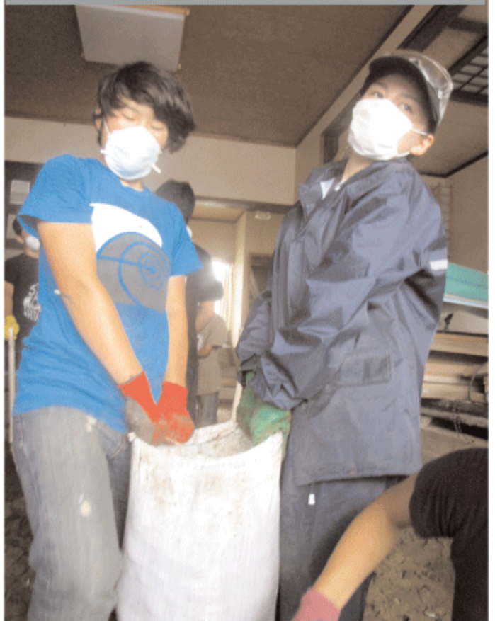
土のう袋は一袋、約25-30キロ! (仙台市若林区)
