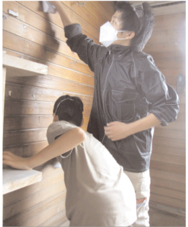
浸水した事務所の水ぶき作業、頼まれて！ (仙台市若林区にて)
