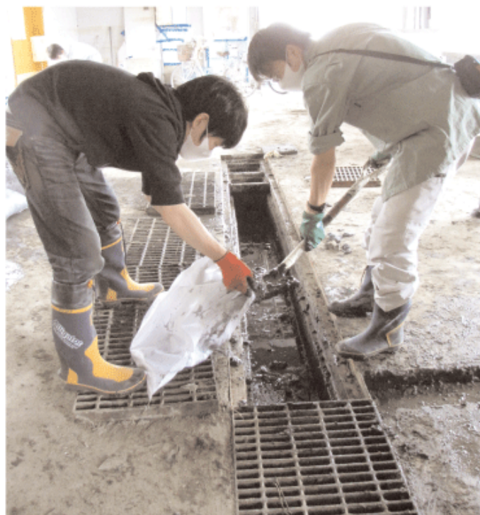
石巻・水産加工場の排水路そうじ (第3回「チア・東北サポート」より)
